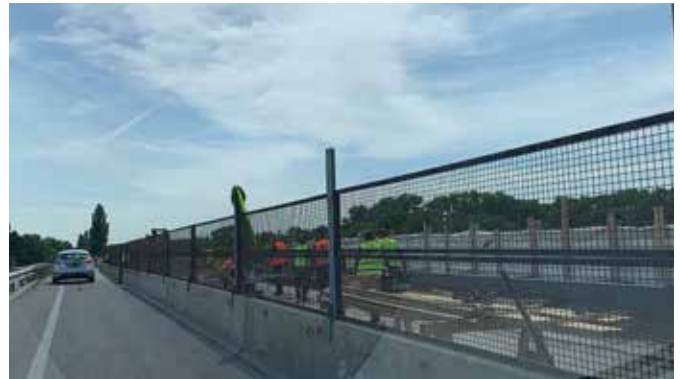
Die Arbeiten am Streifen sind voll im Gange.
