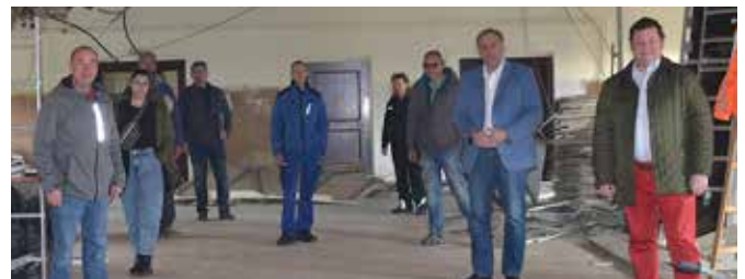
Im Volkshaus wird fleißig umgebaut
